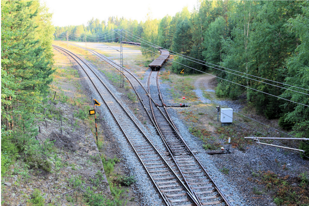
Kuva 5. Ohenmäen raiteisto Ulmalantien ylikulkusillalta etelään nähtynä (kesäkuu 2014).
