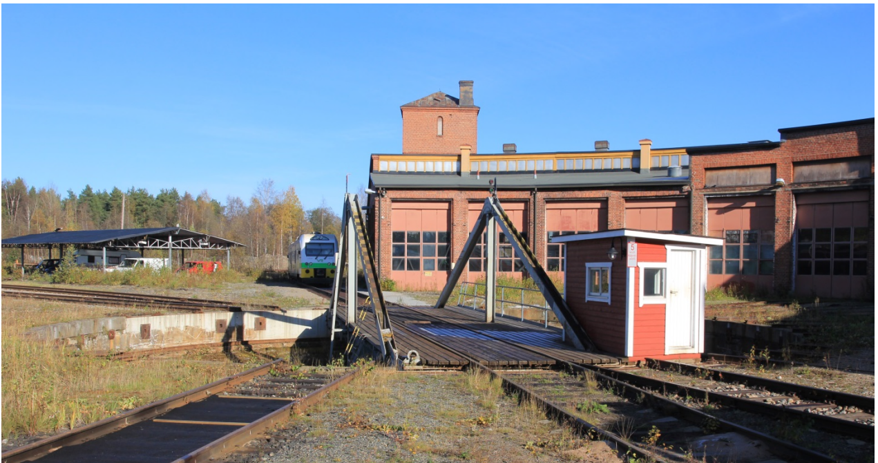
Kuva 16. Kääntöpöytä ja tallin vieressä oleva tunnukseton 56-metrinen raide (lokakuu 2015).
