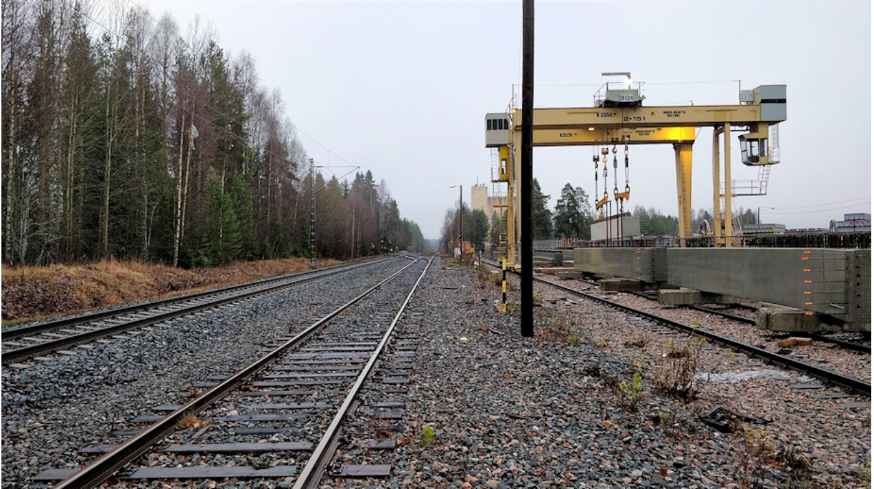
Kuva 8. Peltosalmen raiteisto raiteelta R002 pohjoiseen (marraskuu 2018).
