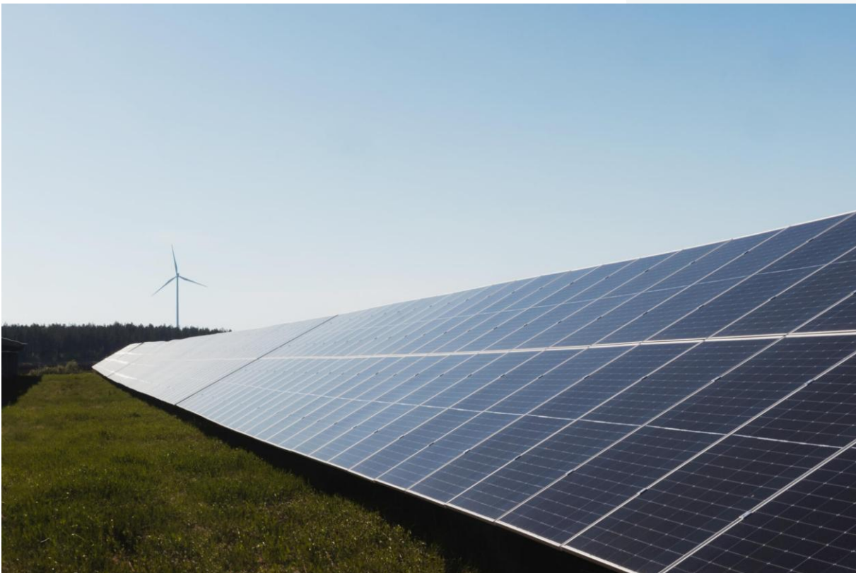
Kuva 1. Paneelirivi teollisen mittaluokan aurinkovoimalassa. (Kuva: Suomen uusiutuvat ry.)
